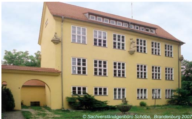
straßenseitige Teilansicht der ehemaligen Schule Blickrichtung Ost
