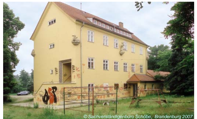
rückwärtige Teilansicht der ehemaligen Schule Blickrichtung West
